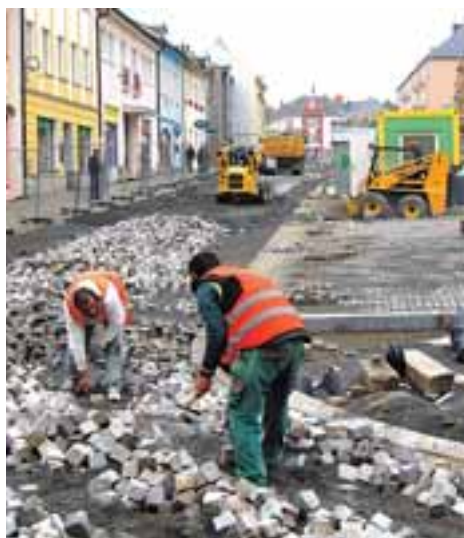
Rekonstrukce náměstí probíhá podle plánu, letošní část skončí v říjnu
