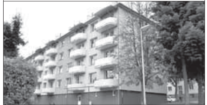
Nově vybudované balkóny domu na Větrné ulici
