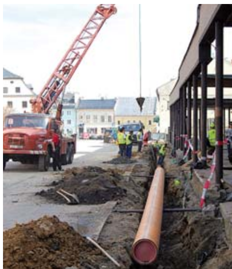
Rekonstrukce náměstí Míru začala obnovou plynovodů
