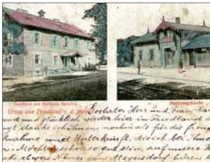
Budova nádraží v Břidličné a hospoda U zlatého větene (1911)
