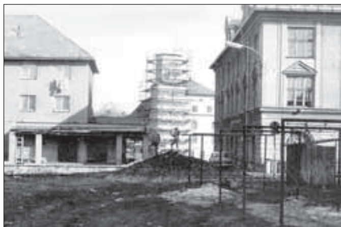
Oprava věže rýmařovské radnice. Stará věž je demontována
