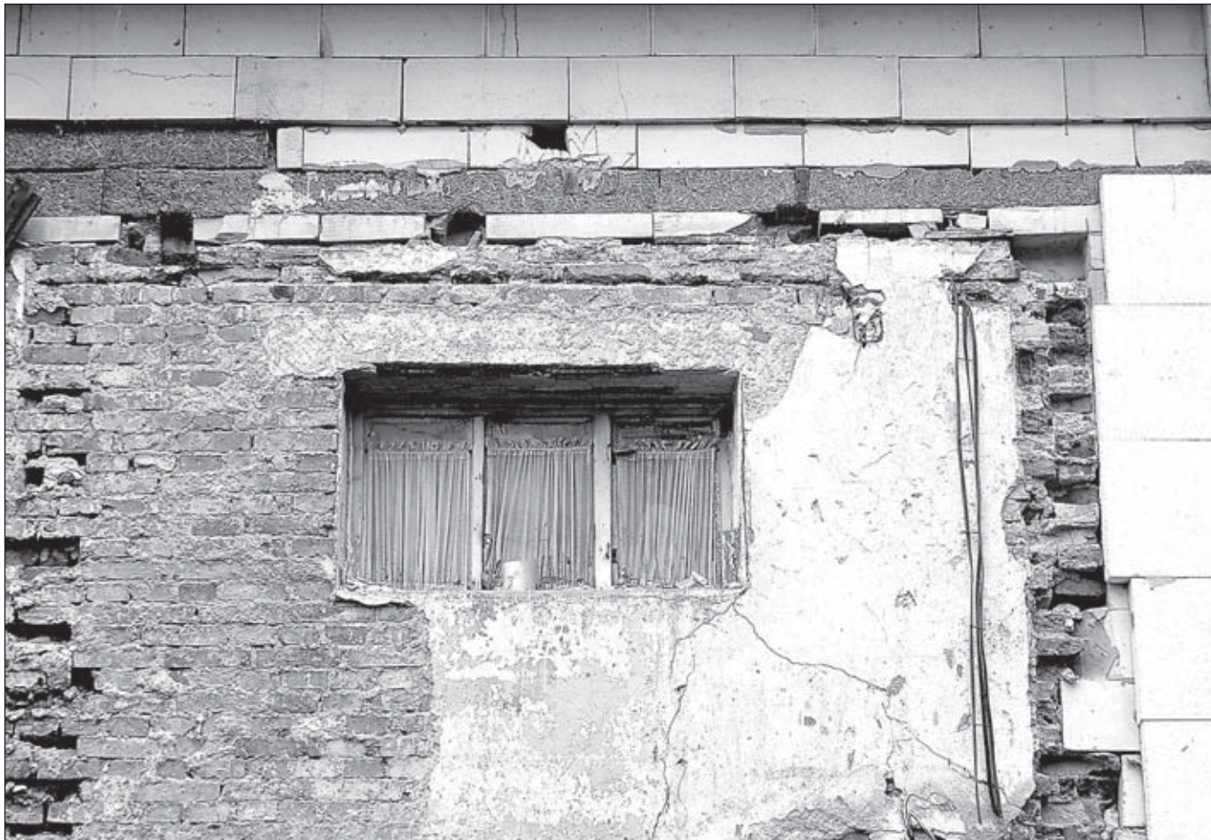
Novostavba vtělila do jedné své zdi i část zdiva zbouraného starého domu - s okýnkem i záclonkou... (Bartákova ul.)
