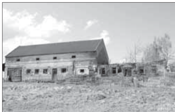
Hospodářská budova v Jamarticích (parc. č. 329)
