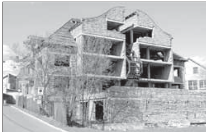
Rozestavěná banka na Husově ulici (parc. č. 55/2 a 56/2)
