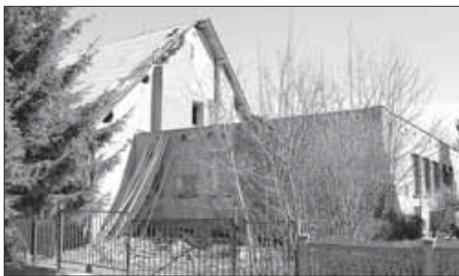
Bývalá prodejna masa a uzenin na Okružní ulici (parc. č. 2493/1), na objekt je vydán exekuční příkaz k prodeji
