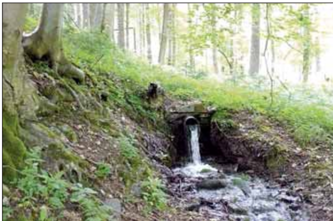
Ústí odvodňovací štolý ve Stráleckém údolí
