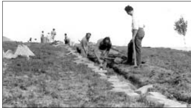
Stavba televizního převaděče nad Janovicemi, 9. 6. 1962
