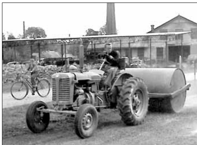
Budování školního hřiště na Palackého ulici, 21. 10. 1961
