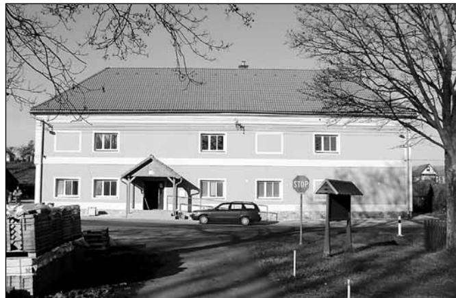
Multifunkční kulturní dům v Lomnici
