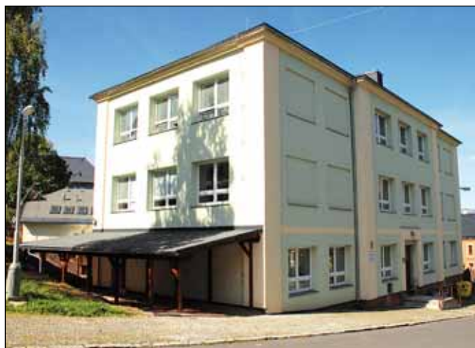
Zateplení ZŠ Národní 15 - školní budova získala v roce 2008 termofasádu a nová okna za 2,9 mil. Kč, část nákladů pokryla dotace Operačního programu Životní prostředí.
