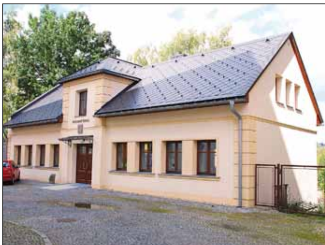
Rekonstrukce školních dílen na Školním náměstí - loni byla rekonstruována budova dílen, kterou využívají žáci blízké ZŠ Školní náměstí, projekt za 6,2 mil. Kč dotací podpořil Regionální operační program Moravskoslezsko.
