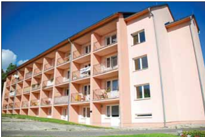
Chráněné byty Lidická - nový domov pro seniory byl postaven v roce 2007 díky dotaci Ministerstva pro místní rozvoj ČR za přibližně 28 milionů Kč na místě někdejší zahrádkářské kolonie.
