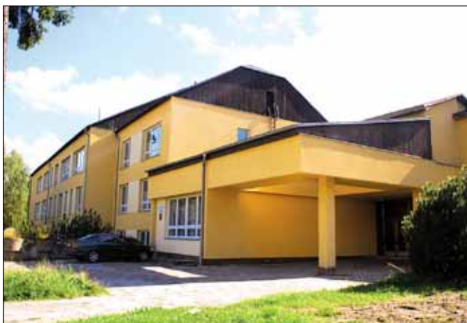
Rekonstrukce ZŠ 1. máje 32 - školní budova byla zateplena za necelých 9 milionů Kč v roce 2007, v následujícím roce byly zatepleny i budovy přilehlé tělocvičny a jídelny za 5,5 mil. Kč, oba projekty podpořila dotace Operačního programu Životní prostředí.
