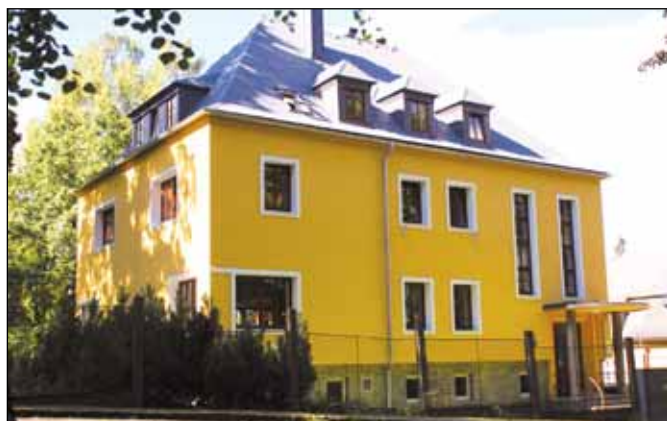
Rekonstrukce MŠ Jelínkova 3 - v tomtéž roce byla dokončena celková rekonstrukce budovy, do níž se poté přestěhovala školka z Revoluční 24, akce stála 13,6 mil. Kč včetně dotace Ministerstva financí ČR a Operačního programu Životní prostředí.
