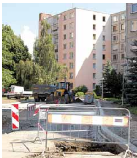
Probíhá první etapa regenerace sídliště Dukelská
