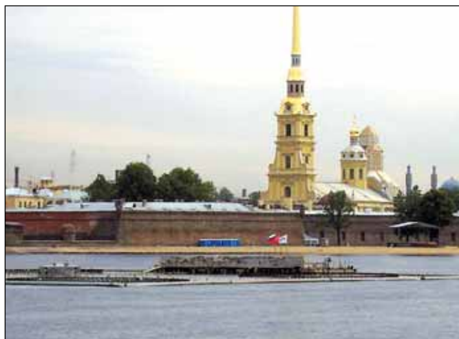
Petropavlovská pevnost, v popředí zařízení pro vodotrysky na Něvě
