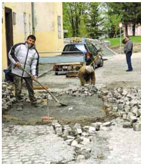
Město opravuje poničené komunikace
