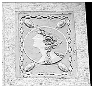
Orament na fasádě restaurace Na Růžku
