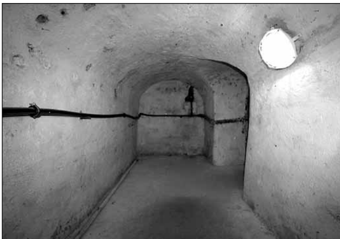
Valeně zaklenutá původní sklepení budovy
