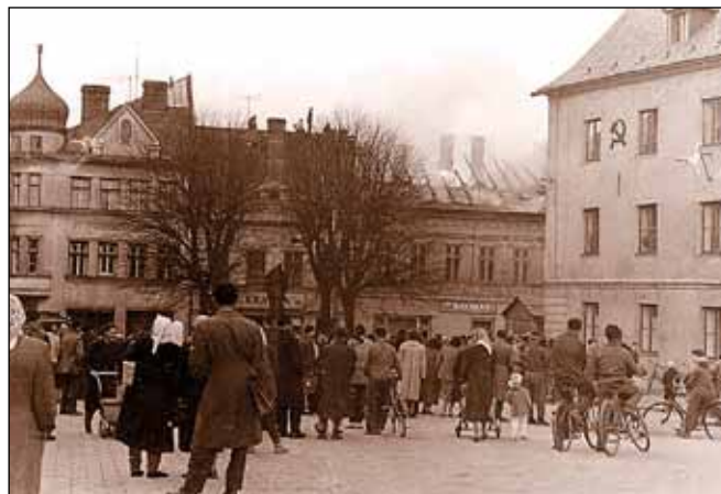
Požár střechy Avionu v Rýmařově, 1959
