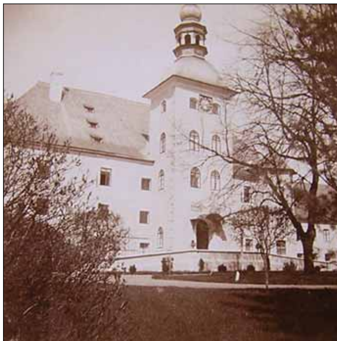
Průčelí zámku v 2. pol. 19. století se vstupní hranolovou věží
