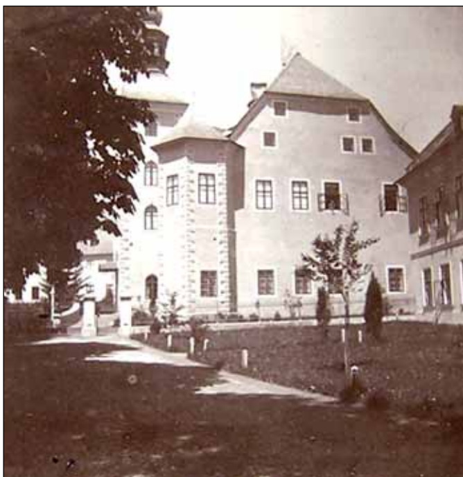
Pohled z pravé strany, nalevo vstupní věž
