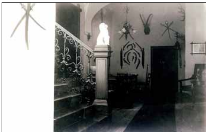
Pata hlavního schodiště
