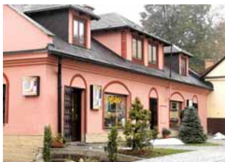
Kam se dřívě zavíralo aneb Bývalá šatlava na Husově ulici
