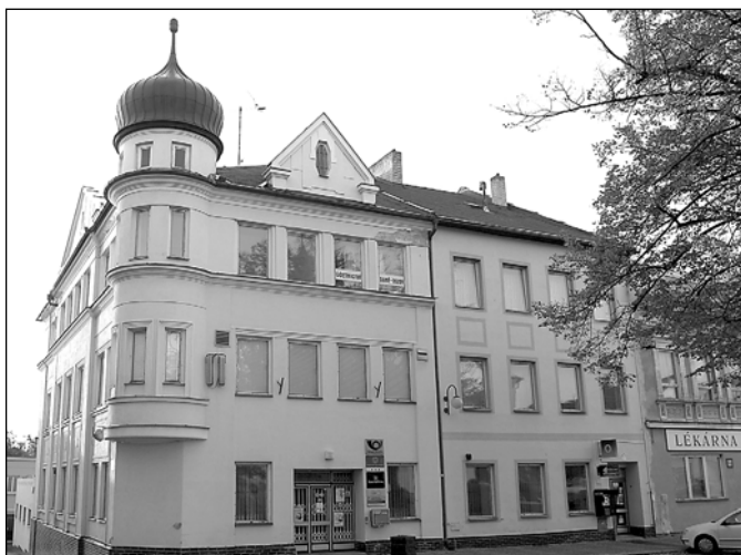
Současná podoba objektu
