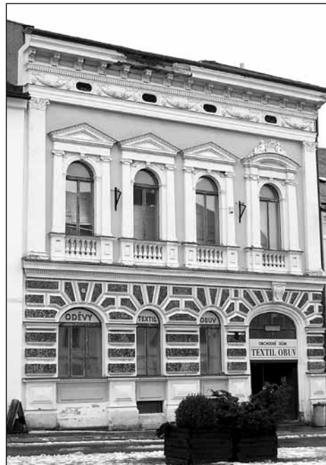
Současná podoba objektu
