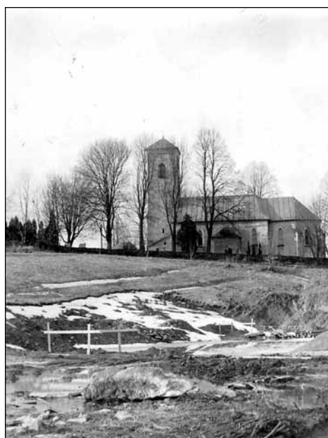
Stavební jáma pro okály na místě vyhořelé rychty
