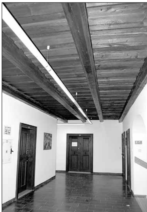
Trámové stropy v interiéru radnice
