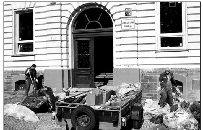
Rekonstrukce budovy ZŠ Jelínkova I
