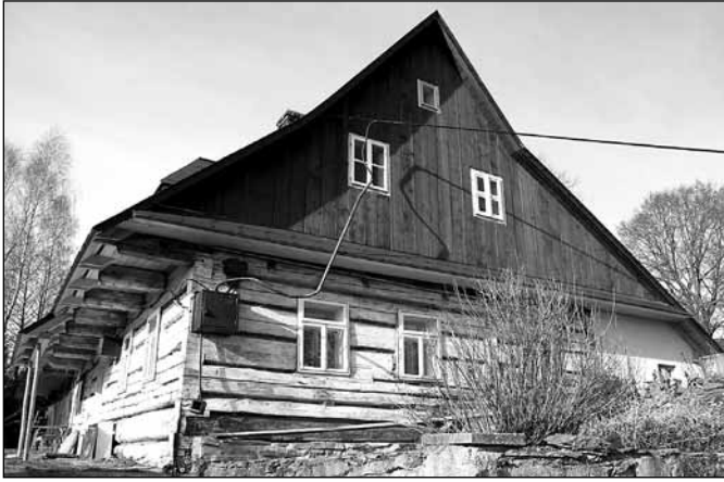
Renovovaná roubená stavba ve Žďárském Potoce
