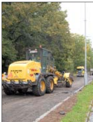
Motoristé budou jezdit po oprá- vených komunikacích
