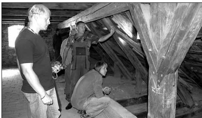
Kontrola trámů po sanaci dřevomorky
