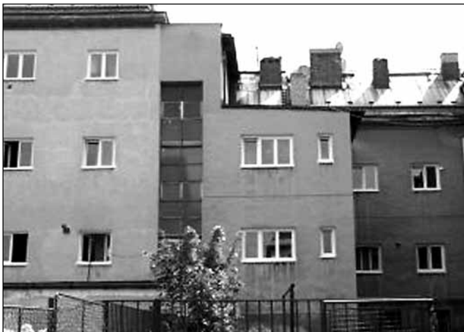
Julia Sedláka 18, výměna oken
