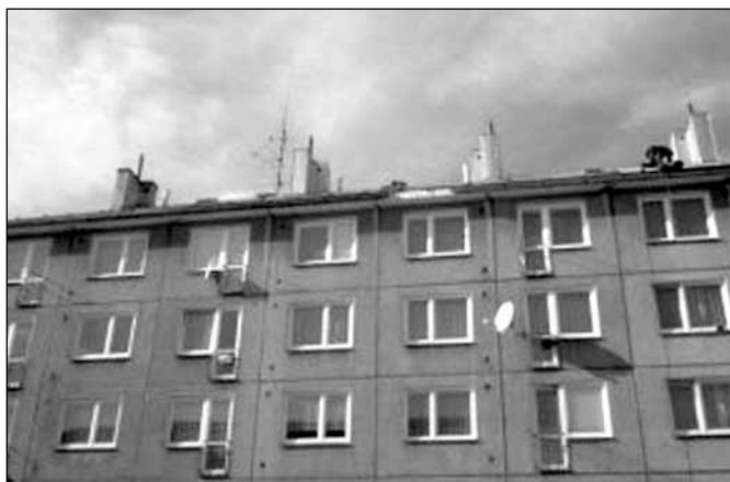
Větrná 9-11, výměna oken
