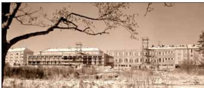
Ulice 1. máje - stavba školní jídelny a tělocvičny, 1976
