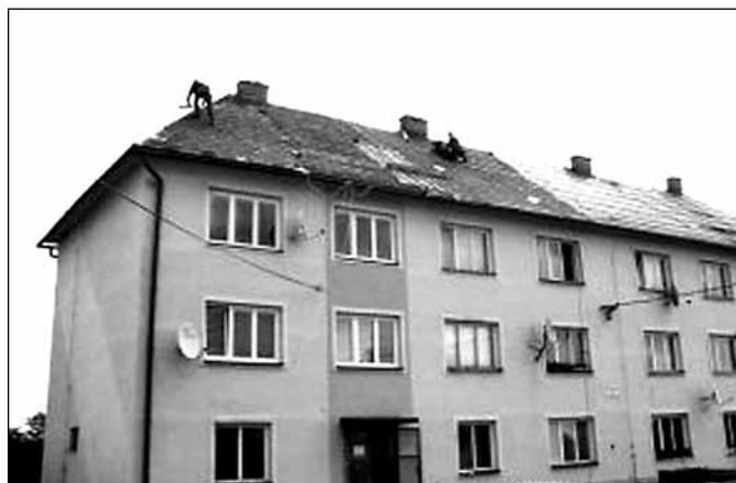
Ondřejov, výměna střešního pláště
