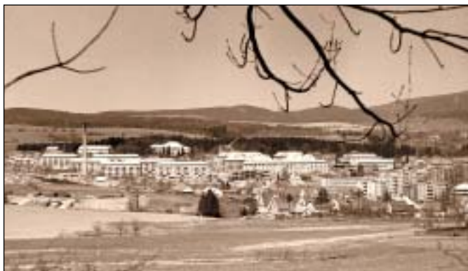
Pohled ze Stráně, stavba školní jídelny a tělocvičny, 1976
