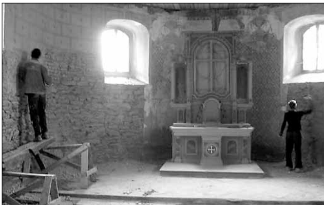
Rekonstrukce kamenné kaple v Pekařově
