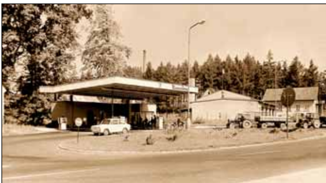
Benzínová stanice s požární zbrojnicí, 1969
