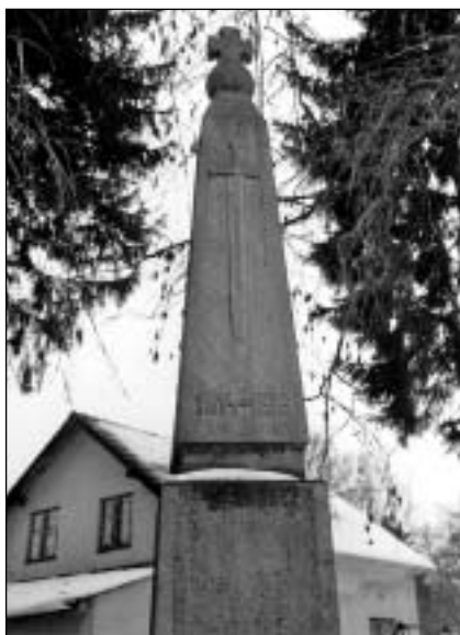
Z kvalitních cihel a z betonové malty postavili pomník v Lomnici tak, že budí dojem kamenného monolitu
