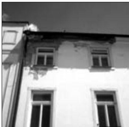
Oprava fasády na náměstí Míru
