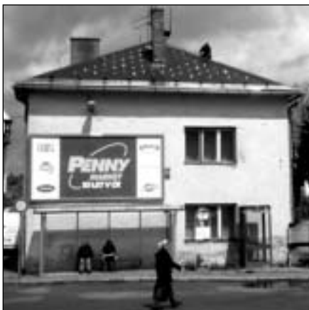
Výměna střechy na ul. T. Matějky 3
