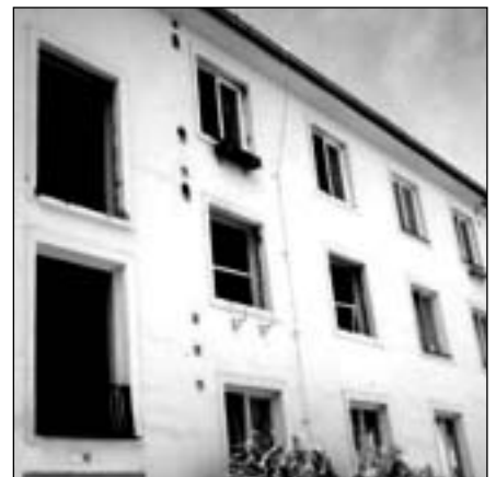
Výměna oken na Sokolovské
