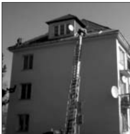
Zvednutí nadokapních plechů na ul. Julia Sedláka
