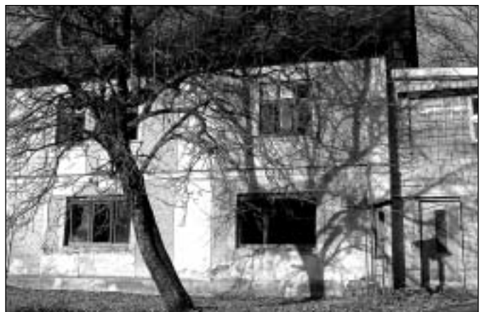
Opuštěná budova Státních statků v Arnolticích
