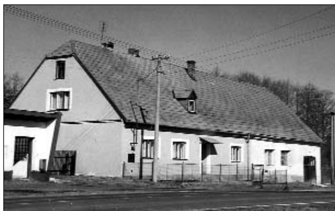
Budova bývalé poštovní přepřahací stanice z r. 1760
