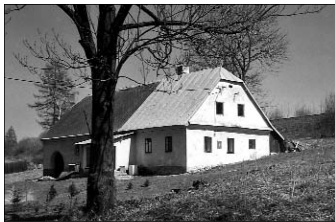
Dům č. 63, Kulturní dům kroužku vzdělanců a pokrokářů v Lomnici „Dům na louce poblíž Nebeské cesty stojící“ z r. 1560
