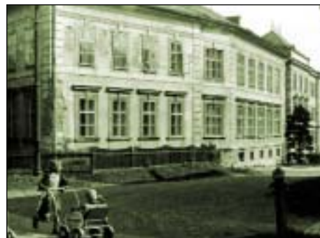
Budova střední školy na Jelínkově ulici (1960)
