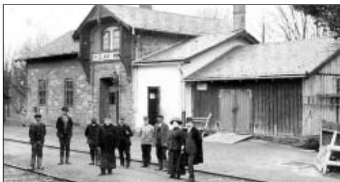
Železniční stanice Břidličná - r. 1924.
